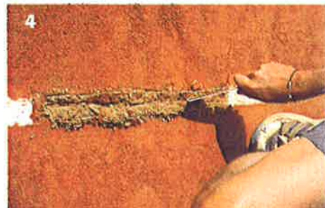
4 Une spatule ou un tournevis servent à décompacter le calcaire. La tranchée ainsi réalisée sera d'une largeur supérieure à celle de la ligne.
