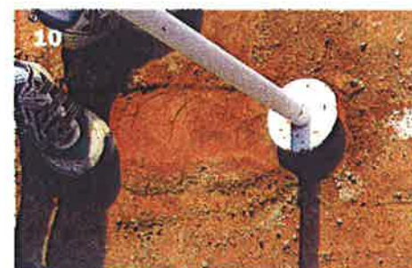
10 On poursuit le compactage à l'aide d'une dame. La base des piquets de simple du filet convient parfaitement à ce type d'opération.
