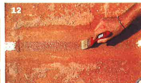
12 Après avoir balayé et laissé la terre sécher, l'huile de lin est appliquée.
