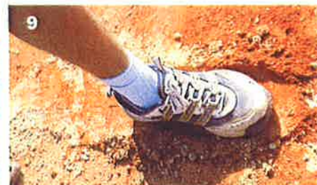
9 L'ensemble est progressivement tassé, tout d'abord avec le pied ; la terre va continuer à se compacter, il est donc impératif de conserver une forme bombée à la réparation.
