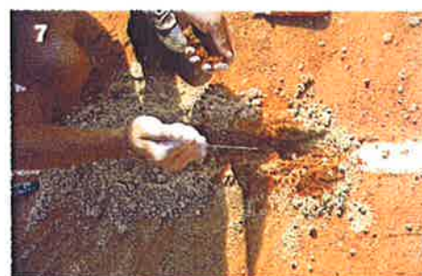
7 La tranchée est ensuite comblée avec l'ancien calcaire mélangé à de la brique pilée.
