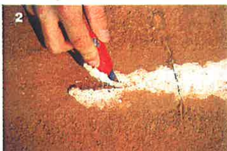
2 La peinture est enlevée à l'aide d'un cutter.
