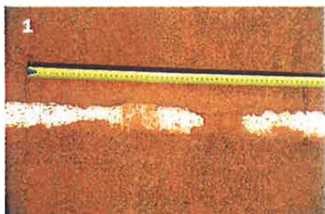
1 La partie de ligne à réparer est d'environ 50 cm.
