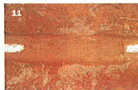
11 La surface de la partie réparée doit être au même niveau que le reste du terrain. C'est là toute la difficulté de la réparation. Un gratta-gé avec la chaussure permet d'y parvenir.
