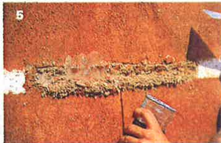
5 Le sol est ensuite humidifié afin de faciliter le travail si la surface est trop sèche.
