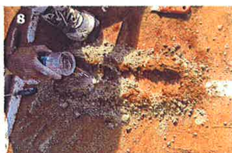
8 Si la terre est trop sèche, l'humidifier légèrement pour faciliter le compactage.
