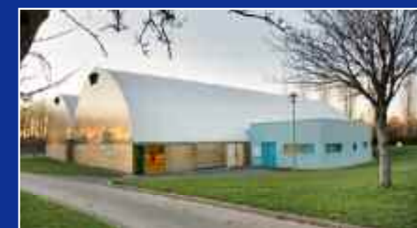
Charpente bois cintrée et habillage bois en partie basse.
