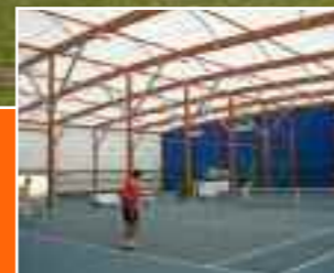
Chapeaux chinois en toiture, charpente bois ou aluminium et habillage bois en partie basse.
