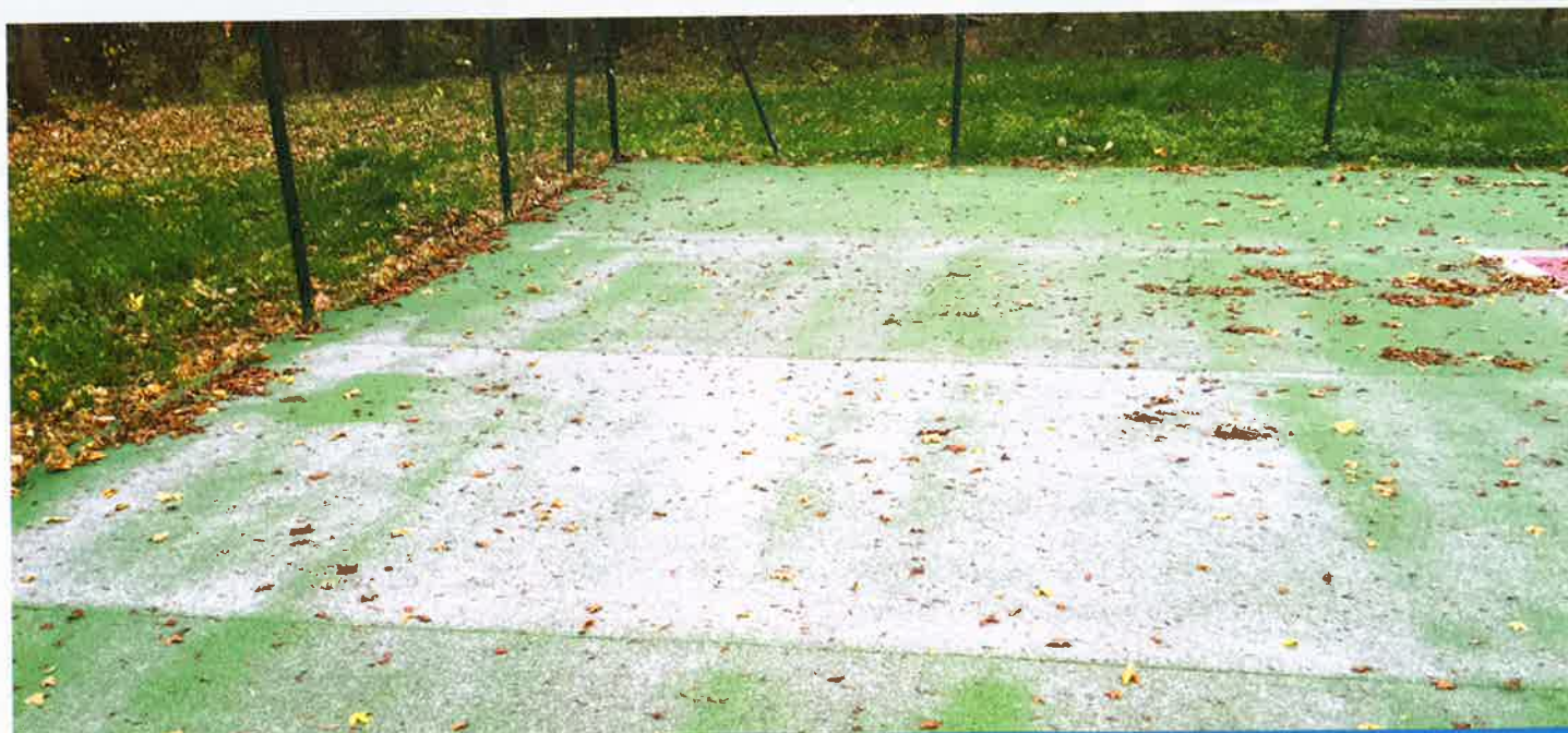
Sur cette photo, l'exemple d'un court en béton poreux récemment livré !
