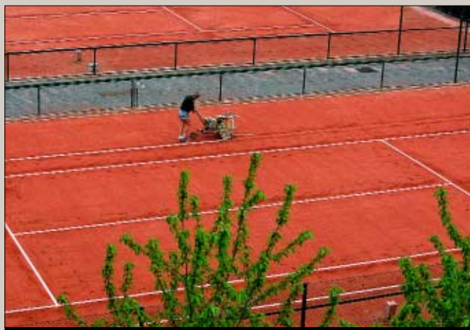
Ultime étape de la préparation des courts : le traçage des lignes.
